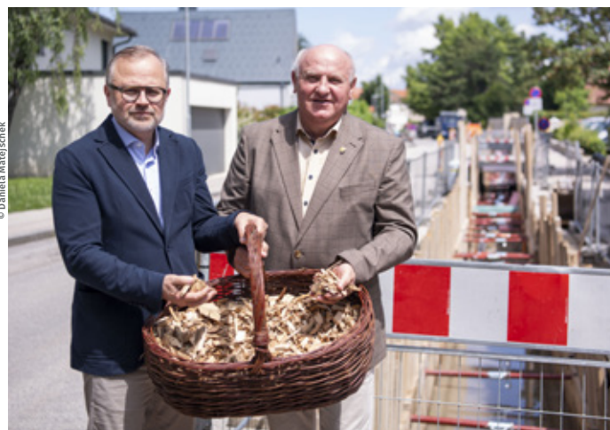
EVN Wärme-GF Alfred Freunschlag und BGM Ernst Wendl setzen auf umweltfreundliche Naturwärme
