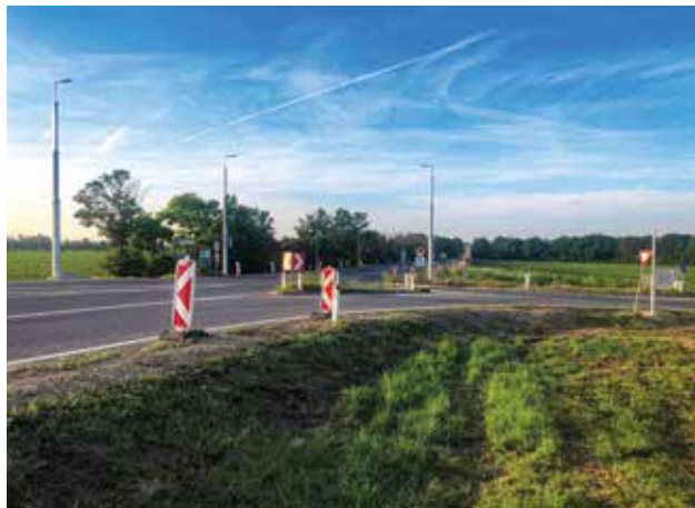
Verkehrssichere Ampel wird an der Kreuzung Gutenhoferstraße/B15a/L150 errichtet
